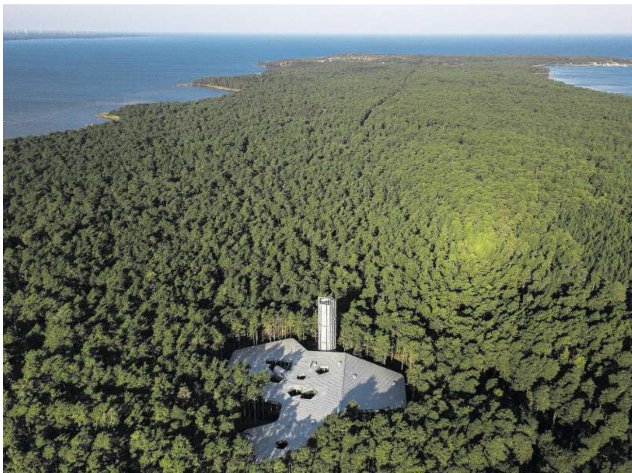
Nur der Turm des Arvo Pärt Centre überragt die Baumkronen auf der Halbinsel Laulasmaa westlich von Tallinn.
